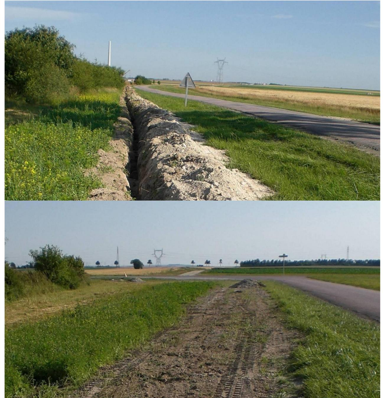
Photo 110 : Rebouchage de tranchée après passage des câbles électriques (Source : BE JC)
